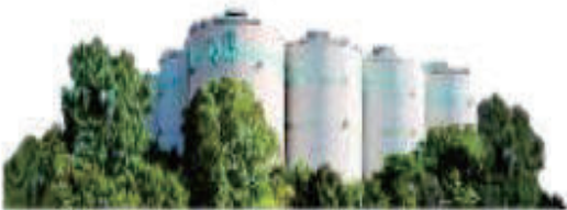
▲キリンビール横浜工場の貯蔵・ろ過塔
