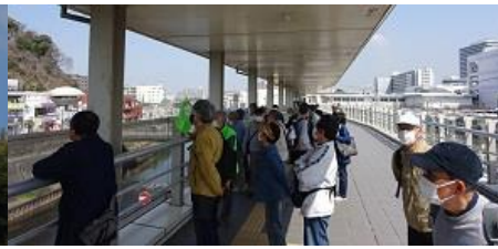
駅連絡デッキ
